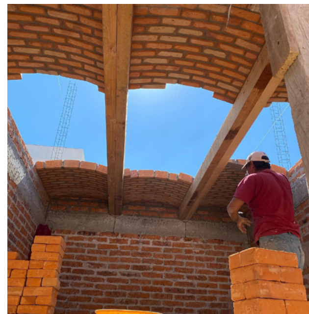
Construcció dels tradicionals revoltos a la manera catalana
